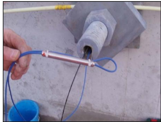
Installatie ankerkrachtsensoren
