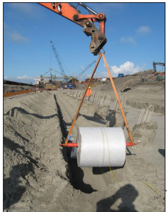
Aanbrengen van het Geodetect®
